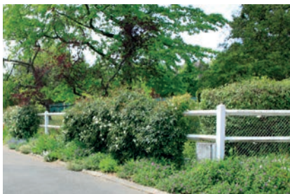
Lisse doublée d'un grillage simple torsion galvanisé.
