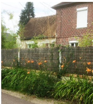
Haie sèche en brande de bruyère.
