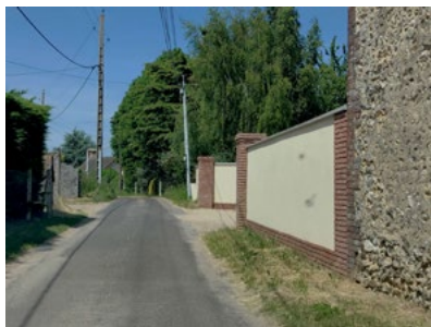
Mur plus classique (parpaings enduits avec sous-bassement et piliers en briques) qui s'inspire des teintes des matériaux traditionnels.
