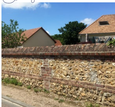
Mur traditionnel (mélange argile/silex/brique).
